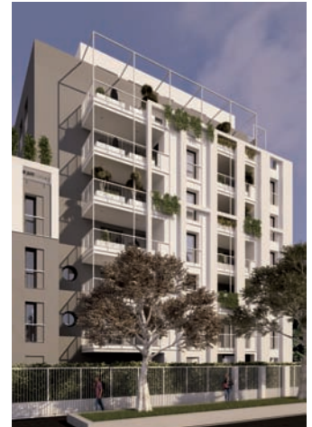
TOLSTOJ 87 - Orti 25 S.r.l. Gruppo Immobiliare La Sorgente di Foresto Sparso (BG) - è un edificio dal design contemporaneo, in zona Soderini - Tolstoj, prevede prestigiosi appartamenti con ampi terrazzi e logge, rifiniti con materiali di prima scelta, impianto domotica, clima, videosorveglianza e tutti a basso consumo energetico.
